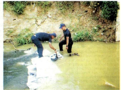
GAMBAR FAIL menunjukkan anggota Lembaga Urus Air Selangor (LUAS) memasang beg activated carbon bagi mengawal pencemaran bau di Sungai Kundang, Rawang. – GAMBAR HIASAN
